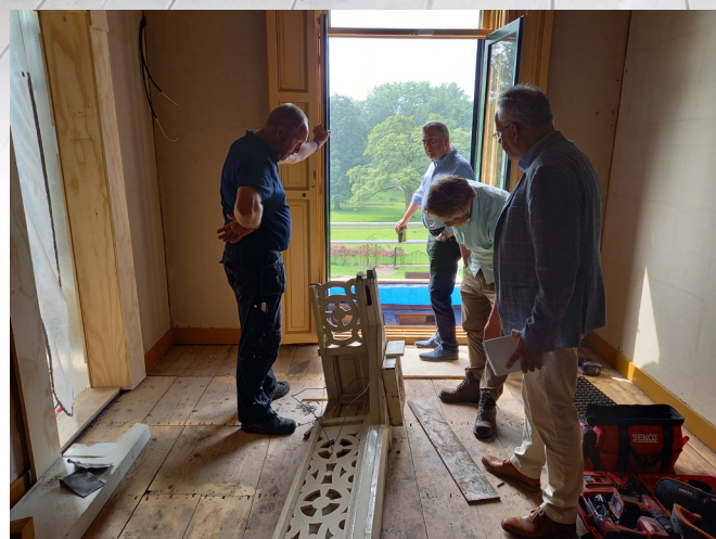
Bouwkundig overleg over het balkon.
