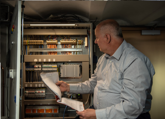
Geert-Jan Hoogendoorn bij de controle van het gedane installatiewerk.
