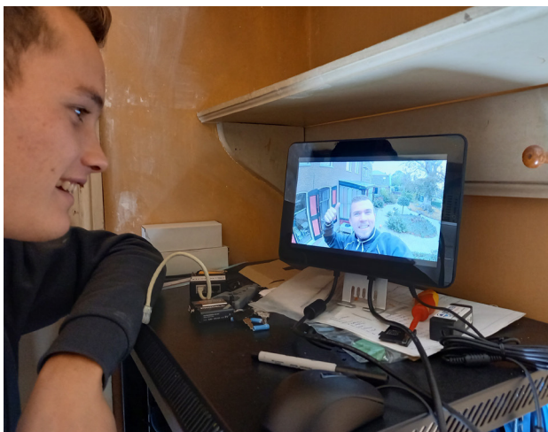
Installatie van cameratoezicht.
