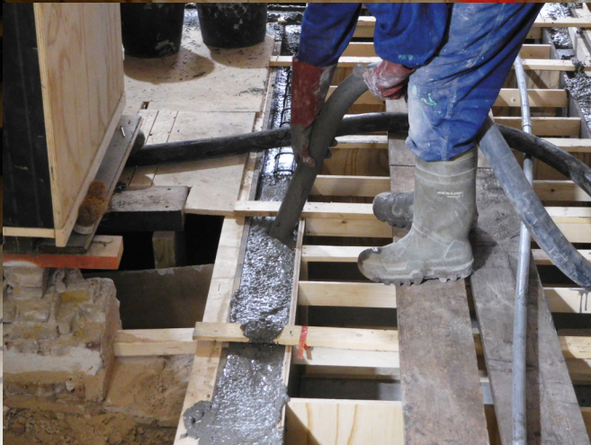
Het storten van beton voor aanleg van leidingen en versterking van de funderingen.
