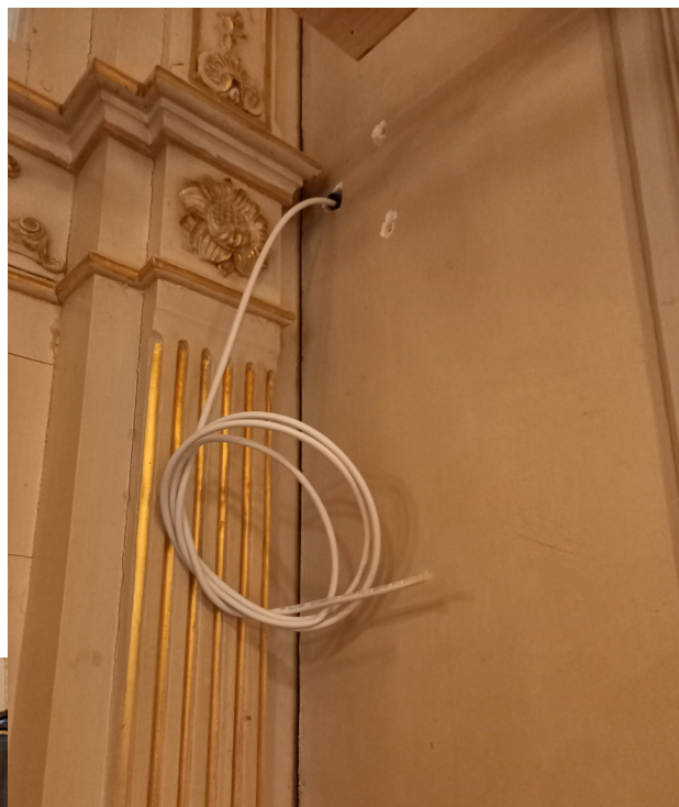
Doorvoer van leidingen in een monumentaal pand vraagt om grote zorgvuldigheid.
